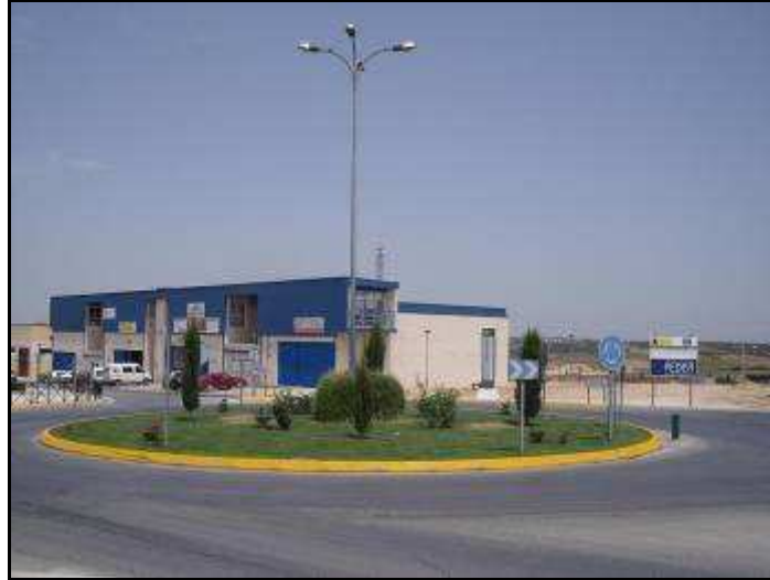
Fotografía 39. Rotonda carretera Puente Genil.
